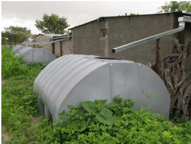
**Abb. 8:** Regenwassersammelanlage mit Polyethylen-Tank bei einem Haushalt in Epyeshona
