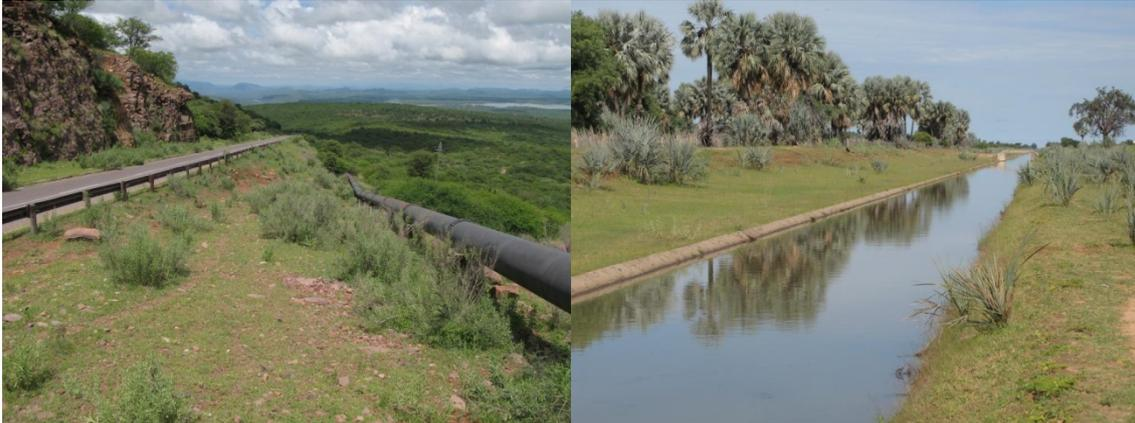
**Abb. 4:** Das Fernleitungssystem mit Pipeline unmittelbar nach der Entnahme am Calueque-Damm (links) und der offene Kanal (rechts) in der Zuleitung zur nachfolgenden Aufbereitung und Verteilung.
